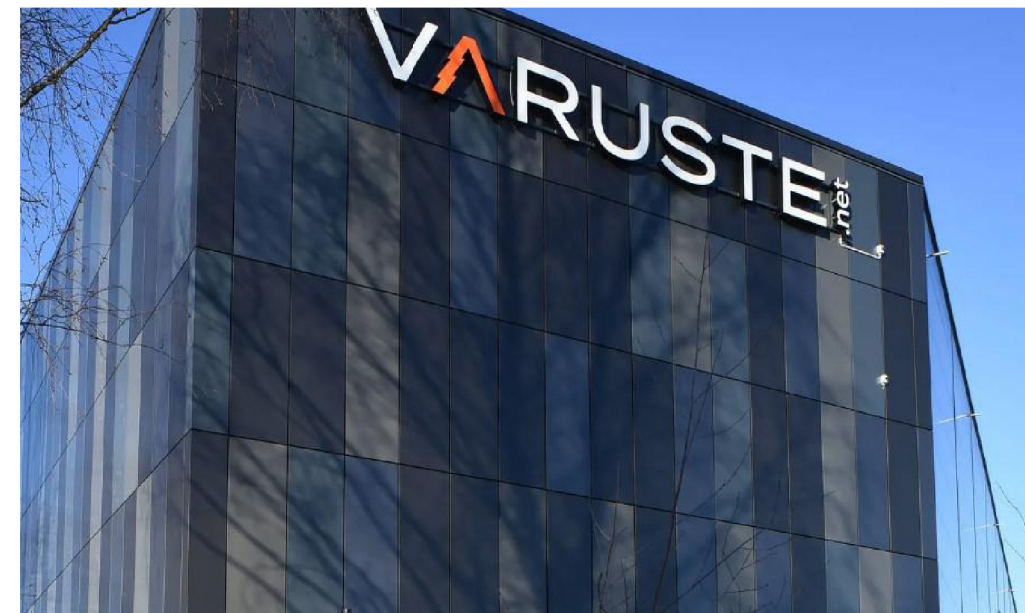
RUUKKI: LIBERTA JULKISIVUKASETTI (mekaaninen pillokiinnitys)
